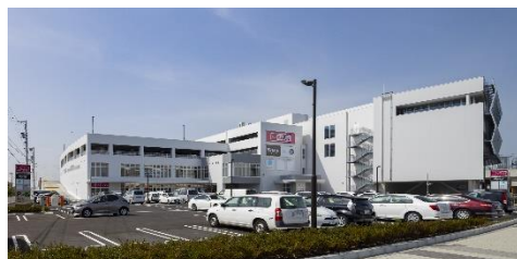
北面都市計画道路より
