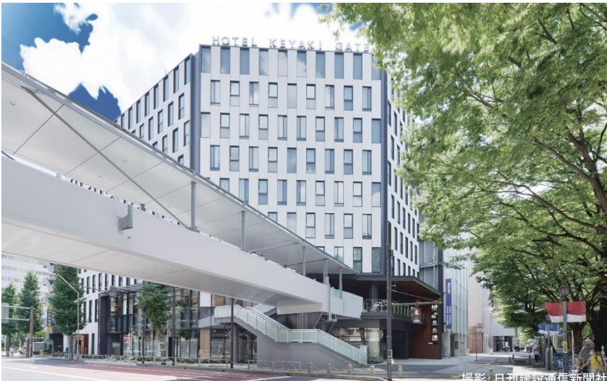
撮影：日刊建設通信新聞社
