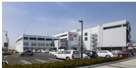
北面都市計画道路より
