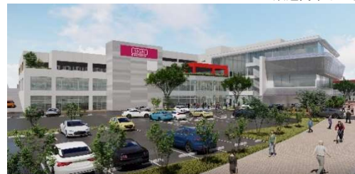
北面都市計画道路より
