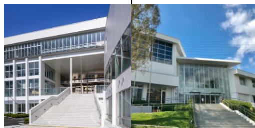
習志野市 大久保地区公共施設再生事業 千葉県習志野市 公共施設(図書館・市民ホール・公民館)・ 公園・駐車場・民間付帯施設 2019年11月開業
