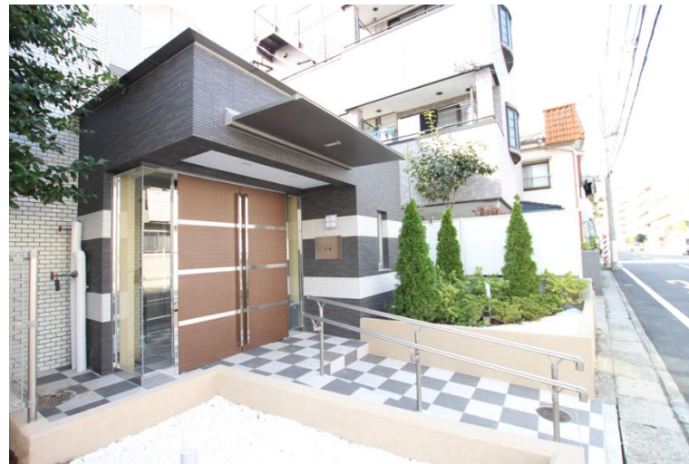
リノベーションにより明るいエントランスに変更
