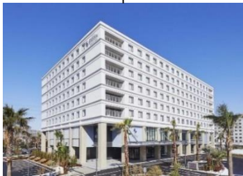
ホテルエミオン東京ベイ新館 千葉県浦安市 ホテル 2018年9月竣工
