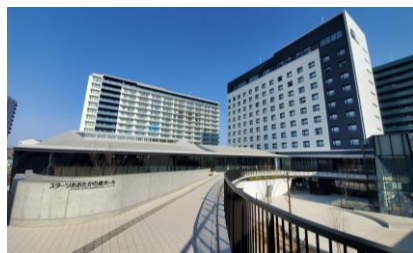
流山おおたかの森駅前市有地開発事業 千葉県流山市 公共施設・ホテル・集合住宅 2019年1月開業(ホテル棟) 2019年4月開業(公共施設棟) 2020年3月竣工引渡(集合住宅棟)
