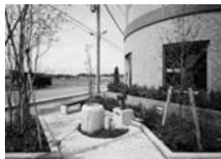
防災井戸の設置
