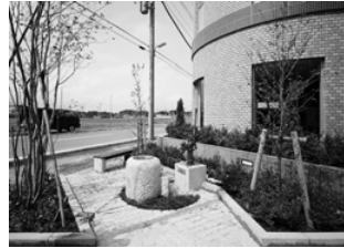
防災井戸の設置
