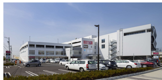
北面都市計画道路より
