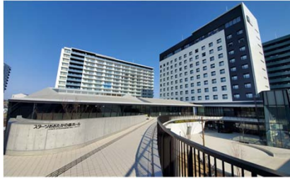
流山おおたかの森駅前市有地開発事業 千葉県流山市 公共施設・ホテル・集合住宅 2019年1月開業(ホテル棟) 2019年4月開業(公共施設棟) 2020年3月竣工引渡(集合住宅棟)
