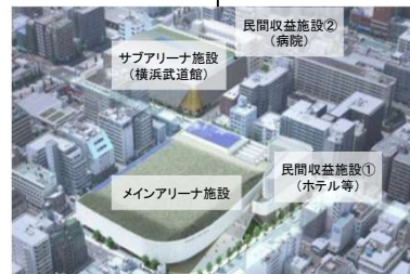
横浜文化体育館再整備事業 民間収益施設①(ホテル等) 神奈川県横浜市 ホテル・店舗・駐車場 2024年4月開業予定
