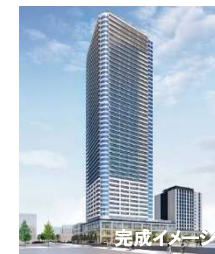
札幌北8西1地区再開発事業 北海道札幌市 ホテル・店舗 2023年6月竣工予定
